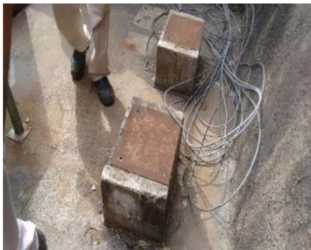
Figura 30 - Base de sustentação de antigo equipamento em área de trabalho, podendo ocasionar tropeços
