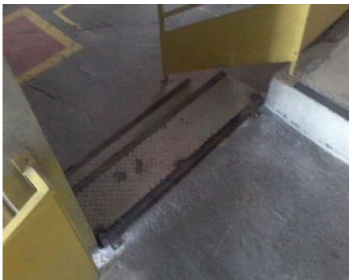
Figura 29 - Escada ajustada e fixada ao piso, eliminado riscos de cair e tropeçar
