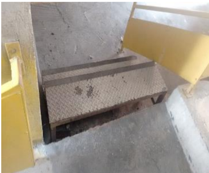
Figura 28 - Escada solta, com abertura que permite tropeçar e cair
