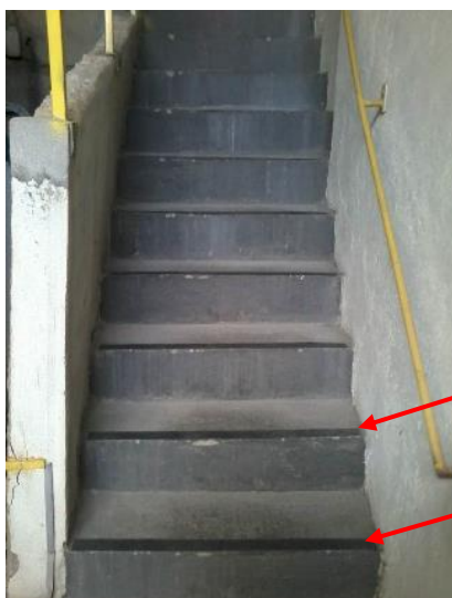
Figura 33 - Risco de escorregar mitigado com a instalação de fitas antiderrapantes
