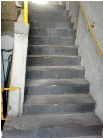
Figura 32 - Risco de escorregar em escada devido à ausência de material antiderrapante
